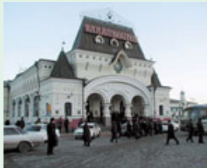
ウラジオストク中央駅 シベリア鉄道の起点。モスクワまでは9,297キロ。庁舎は1912年に建設された。
